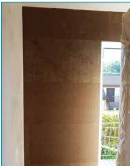
Nobilium®Thermalpanel posato su parete interna senza uso di tasselli con ciclo di calce naturale.
